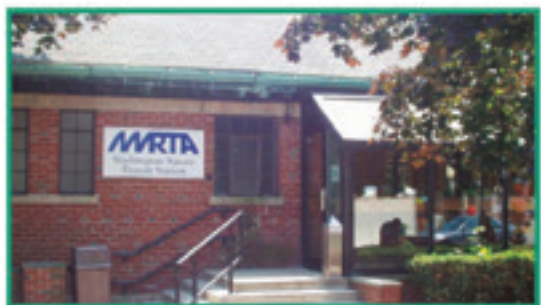
Estación de Tránsito en Washington Square, Haverhill
